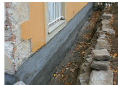
Bild 4.15: Einbringen einer schützenden Dichtschlämme nach Entfernung der Injektionsventile
