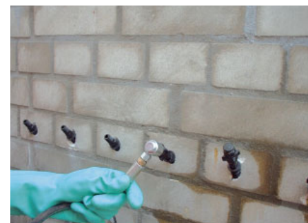
Bild 4.14: Druckinjektion: Ansetzen eines Injektionsschlauchs an die Ventile
